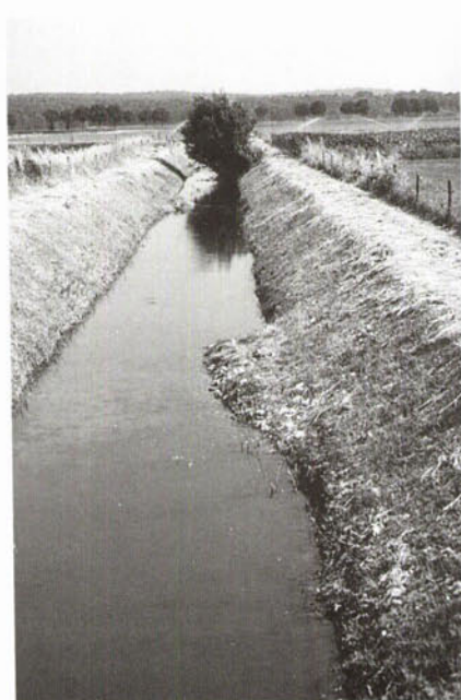
FIGUUR 3. Lokale inrichtingsmaatregelen in de Kroonbeek: a) driehoekskribben met stenen (voor) of met wilgeaanplant (achter) b) beplanting met Zwarte els op de waterlijn. De wijze van schoning (zie foto a) beperkt vooralsnog de kansen voor ecologische ontwikkelingen.
